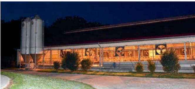
*Ansicht des Stallgebäudes von Familie Griesser in den Abendstunden, mit einem Teil der 18 neu eingebauten direkt angetriebenen Ventilatoren zur Verbesserung der Lüftung an heißen Sommertagen.*
